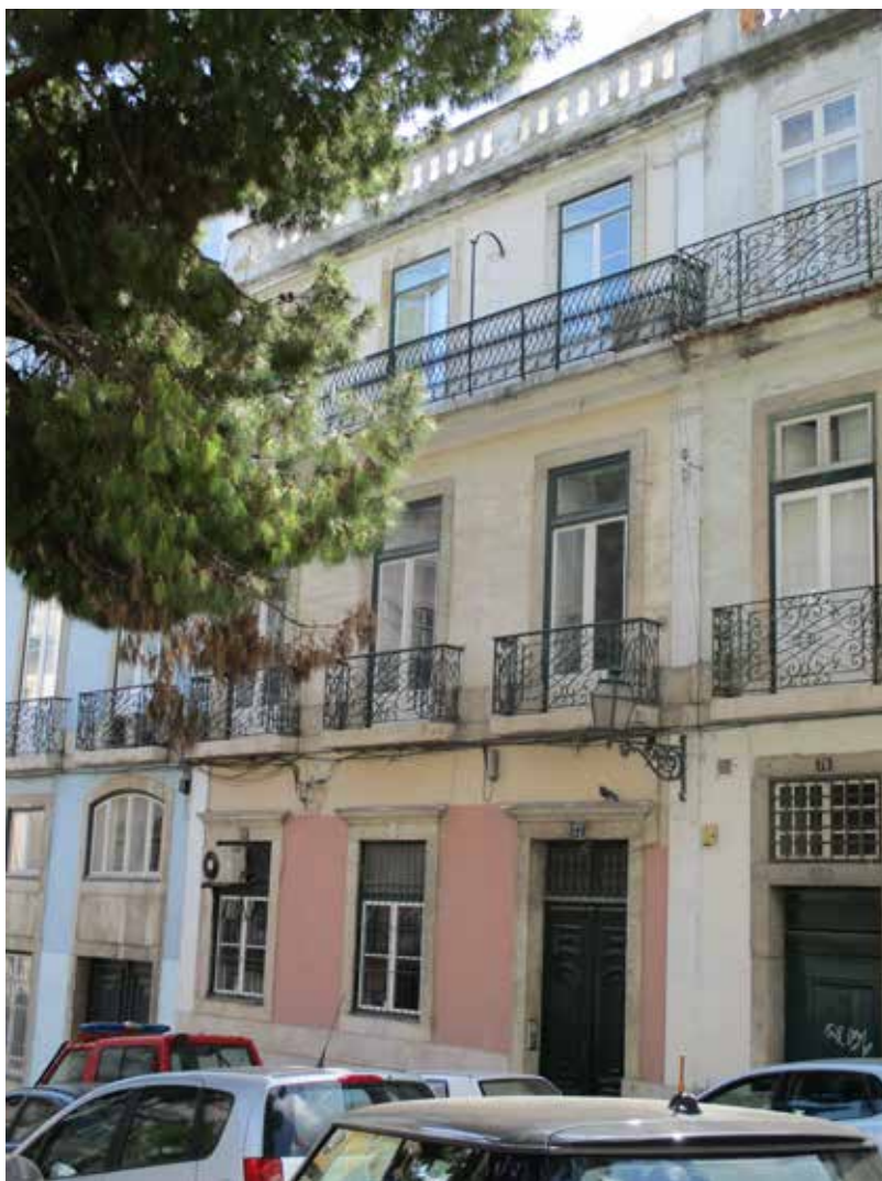
Figura 2 - Fotografia atual do imóvel onde residiram Eugênia e Jerônimo Ferreira das Neves à época de seu testamento (1897), situado na Rua das Flores, nº77, Chiado, Lisboa. Fotografia da autora, junho de 2018.
